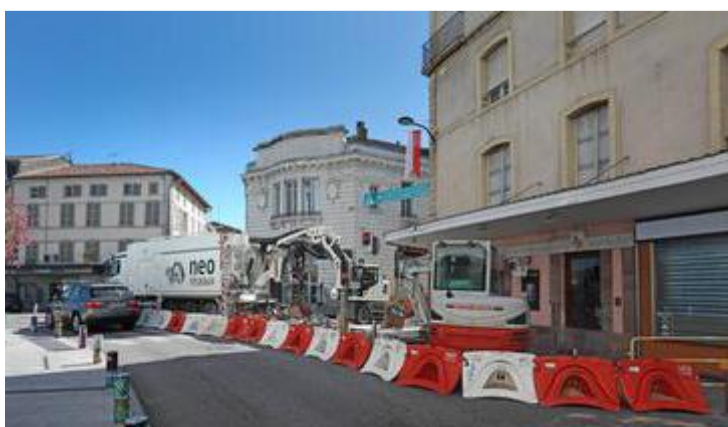
La voie qui longe l'hôtel Splendid est interdite aux véhicules en raison de travaux dans le cœur de ville. PHILIPPE SALVAT
